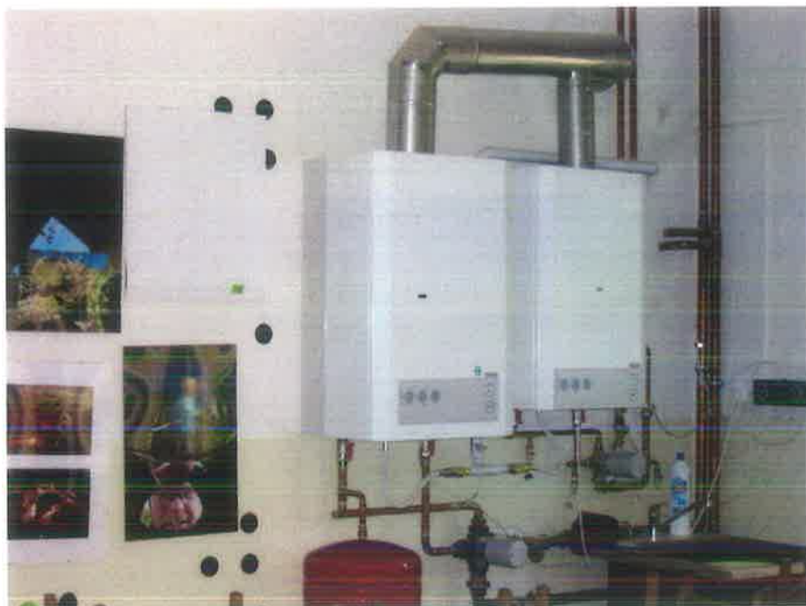
Plynové nástěnné kotle etážového vytápění
